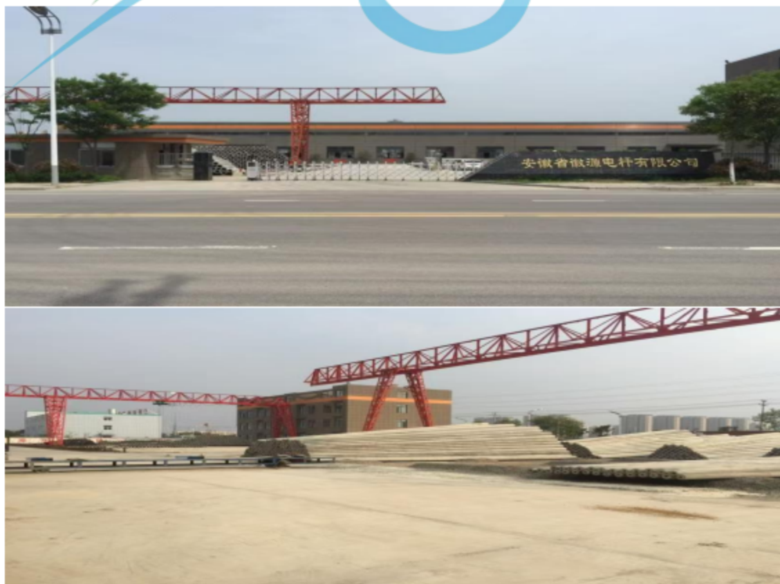
图 2-4 厂区设备照片
