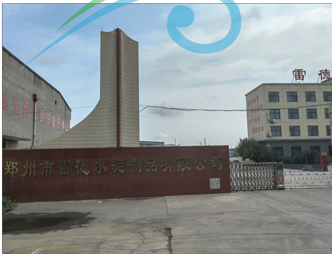
图 2-4 厂区设备照片
