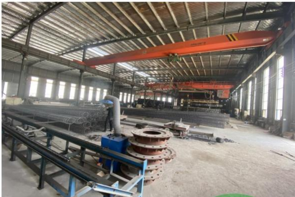
图 2-4 厂区设备照片
