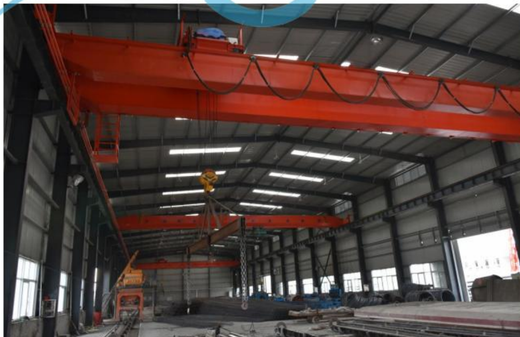
图 2-4 厂区设备照片
