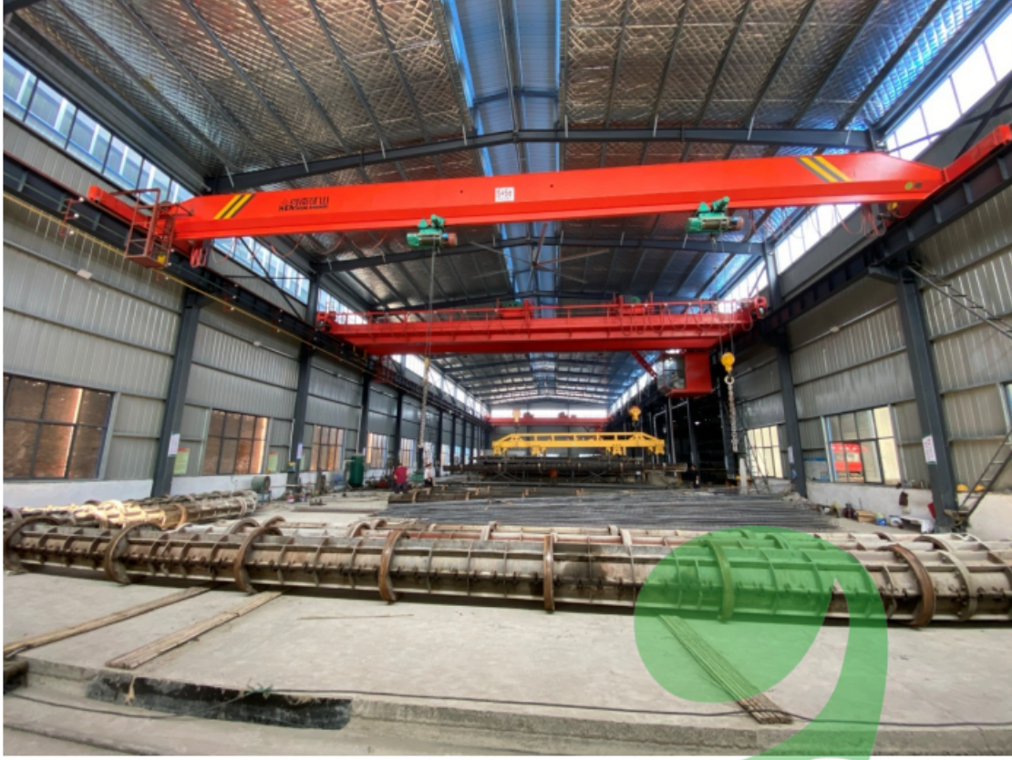
图 2-4 厂区设备照片
